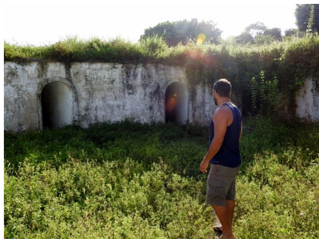
Acesso às 2 galerias subterrâneas
